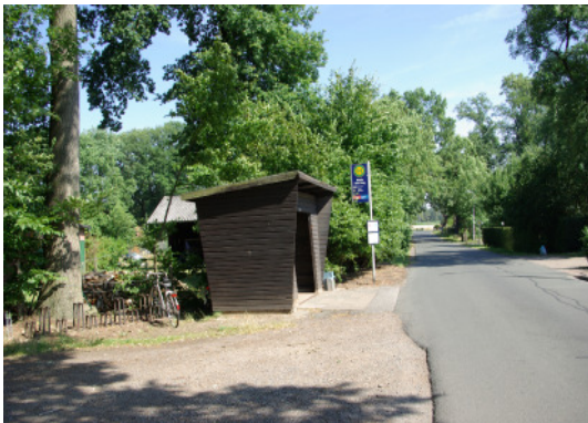
Abb. 18: Erneuerungsbedürftiges Buswartehaus in Nöpke
